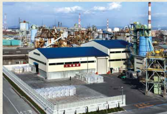
燃料系廃棄物処理設備(宇部セメント工場)
