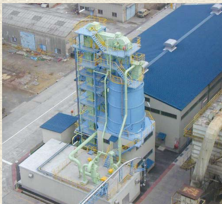
荻田セメント工場破砕設備
