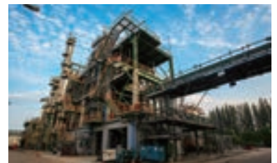
タイで稼働中のPCD 1期製造設備
