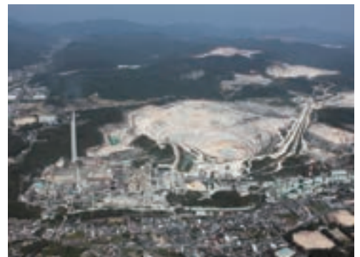
伊佐セメント工場全景
