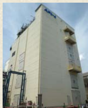
第四医薬品製造設備
