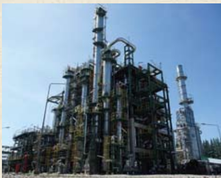
タイ国の1,6-ヘキサジオール製造設備
