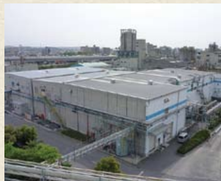
第7期機能膜(セパレーター)製造設備
