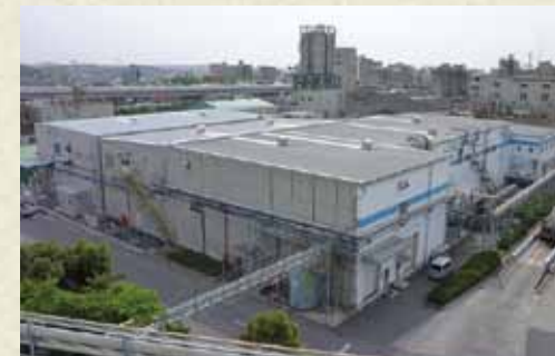
第7期機能膜(セパレーター)製造設備(宇部ケミカル工場)
