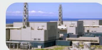
東京電力(株) 柏崎刈羽原子力発電所 (写真: 東京電力)
