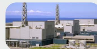
東京電力(株) 柏崎刈羽原子力発電所 (C) 東京電力
