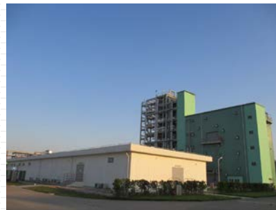
AETZ中国(張家港) 電解液工場写真
