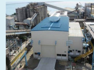
苅田排熱発電設備
