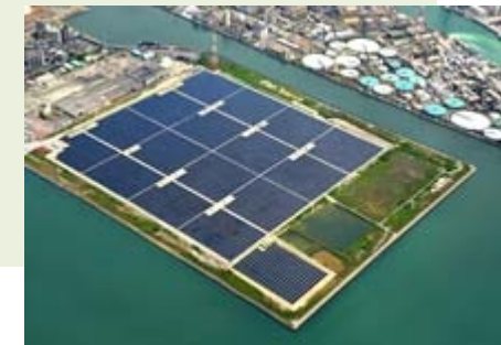
メガソーラー発電所 (14年7月営業運転開始)
