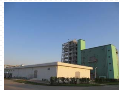
AETZ中国(張家港) 電解液工場写真
