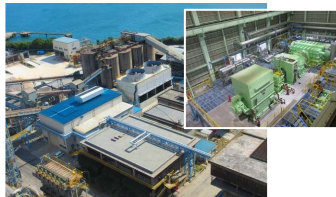
刈田セメント工場 排熱発電設備
