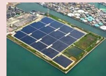
ユーエスパワー発電所
