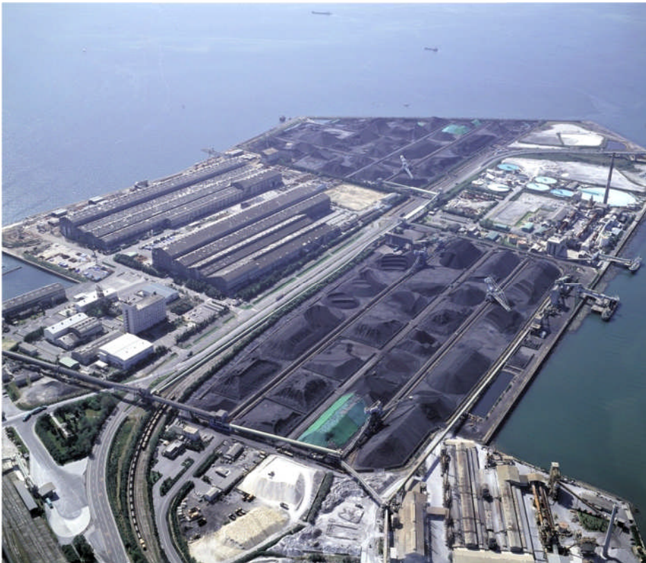
【沖の山コールセンター】（石炭中継基地）
