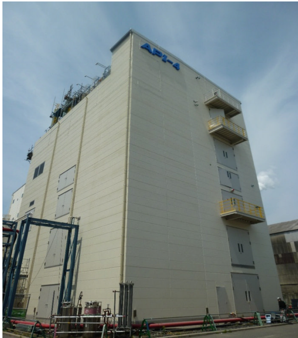
【第四医薬品製造設備】
