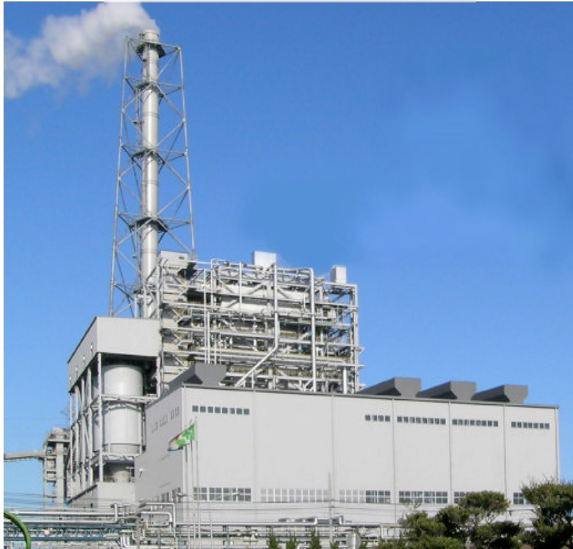
【216MW IPP発電所】
