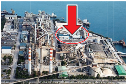
④ 刈田セメント工場の排熱発電
