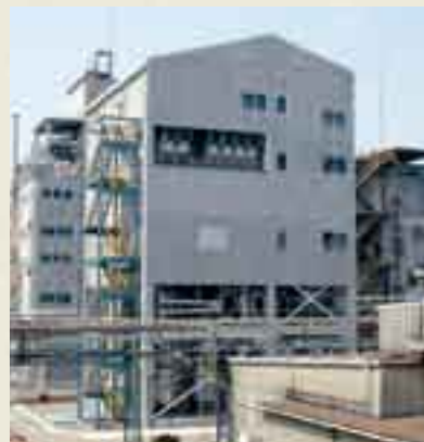
第3期ポリイミド中空糸製造設備
