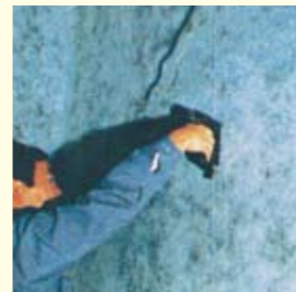
(4) ジョイント部の処理
