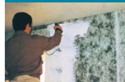
タイル乾式工法
