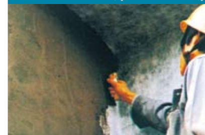
タイル湿式工法(ノンラス工法)
